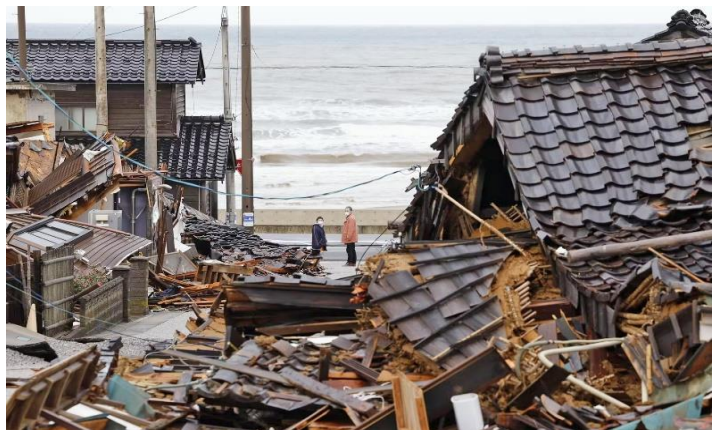
石川県輪島市の倒壊した家屋
