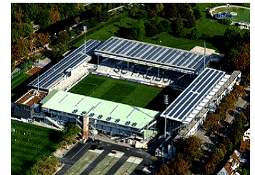
サッカースタジアムの屋根にパネル設置(パネル毎に株主を募集)
